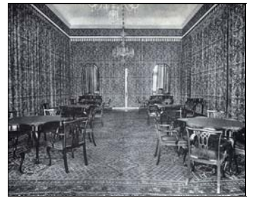
<그림 17> Excelsior 게임장의 실내 텍스타일 장식(1920년대 말)
